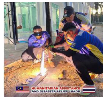
Pemasangan lampu solar
